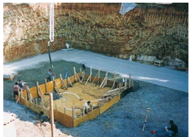
Construcție clădire, Turcia
