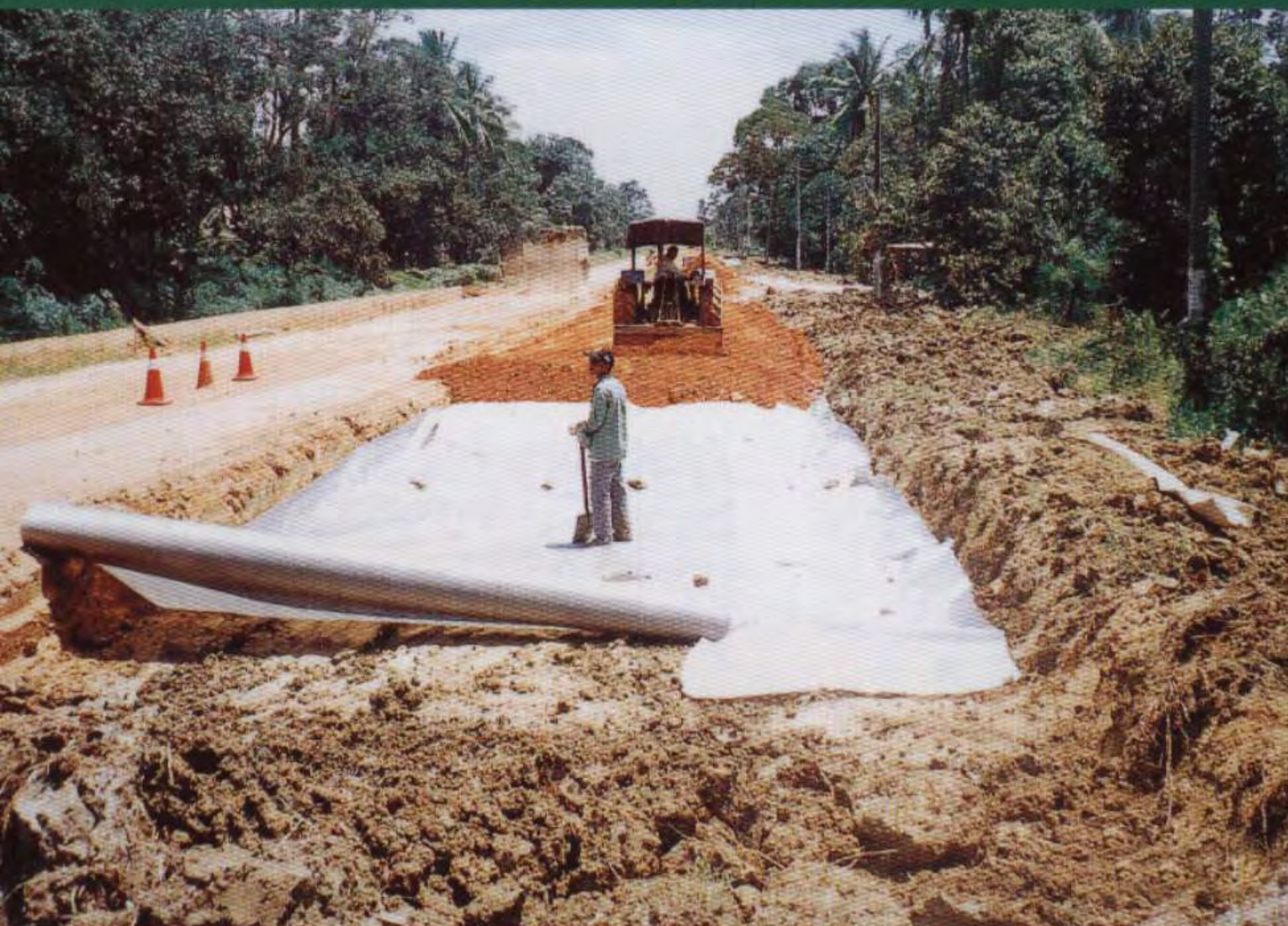
Budowa drogi (Malezja).
