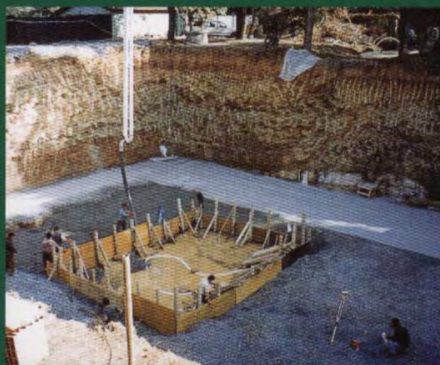
Posadowienie budynku (Turcja).
