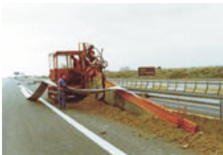
33 pav. Sudėtinio drenažo klojimas kelkraštyje.
