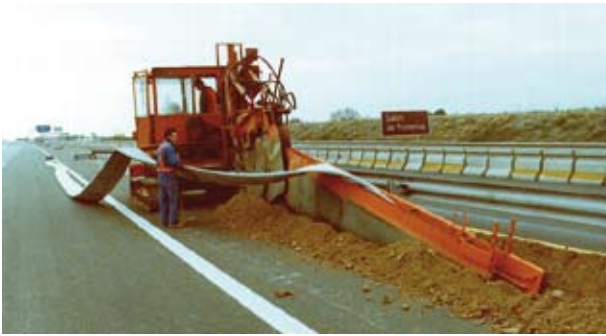
Figura 33: Instalación de compuesto de drenaje como sistema de drenaje de talud para carreteras.
