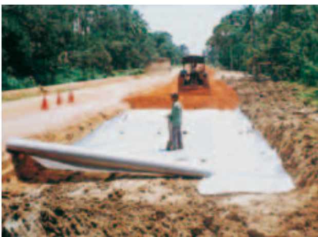
Carretera en construcción, Malasia
