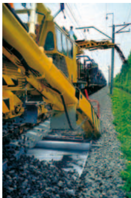
Renovación de vía de ferrocarril entre Moscú y San Petersburgo (Rusia)
