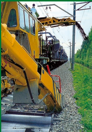
Gleiserneuerung zwischen Moskau und St. Petersburg (Russland)
