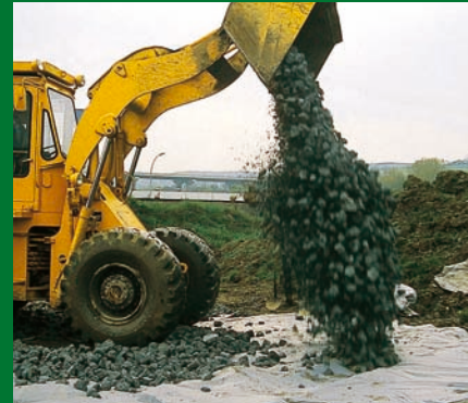
Versuche zur Einbaubeschädigung
