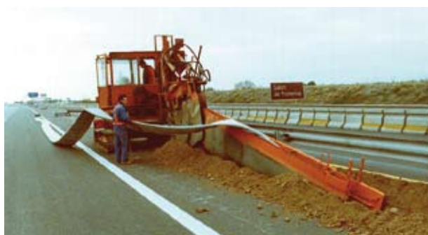
Figure 33 : Installation de composite de drainage comme drain de talus pour route.
