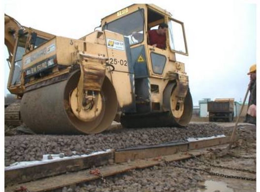
Verdichten (4 Durchgänge)
